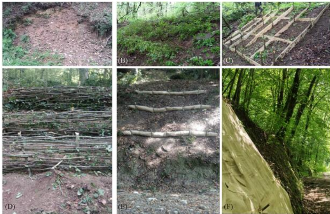
شکل ۳- انواع تیمارهای زیست‌مهندسی مورد مطالعه شامل (A) هیدرومالچ، (B) چپر زنده، (C) تثبیت سلولی، (D) چپر مرده، (E) تثبیت بالشتکی و (F) زمین‌پارچه.
