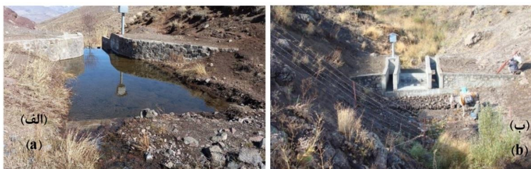
شکل ۲- نمایی از رو به پایین فلوم هیدرومتری و مخزن رسوب زیرحوضه شاهد (الف) و نمایی از رو به بالا فلوم زیرحوضه نمونه (ب). Figure 2. Downward view of hydrometric flume and sediment reservoir of control watershed (a) and upward view of treated watershed flume (b).
