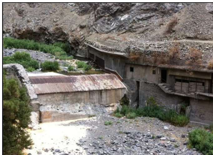
شکل ۱- تصویر آبگیر کفی در رودخانه با میله‌های طولی.
