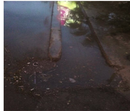
شکل ۶- نمایی از آب‌گرفتگی کانال شماره ۹۲ ناشی از تجمع انباشت زباله.
