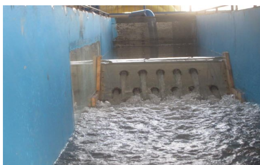
شکل ۴- خروج آب از کلیه لوله‌ها و سرریز.
