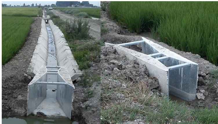
شکل ۶- نصب پارشال فلوم در ورودی کانال‌های بتنی و خاکی.
