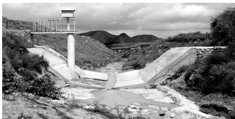
شکل ۱- فلوم احداثی در خروجی حوزه آبخیز کچیک.
